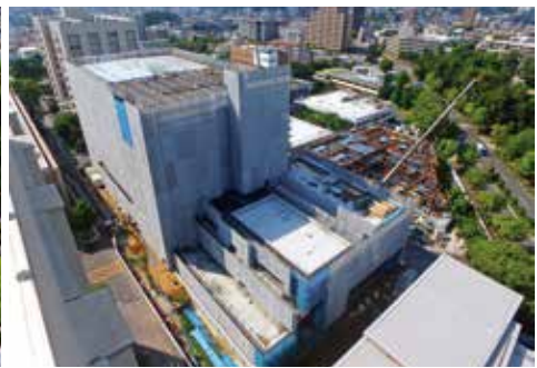
教育研究棟R階躯体工事、福利厚生棟鉄骨建方状況
