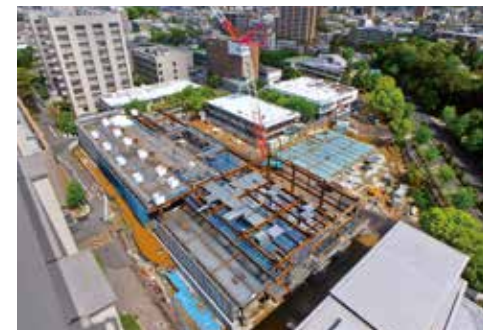
1節鉄骨建方状況
